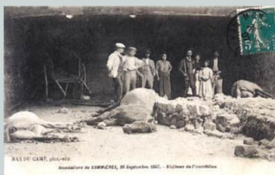
Sommières (Gard) ; victimes de l'inondation du 26 septembre 1907.
